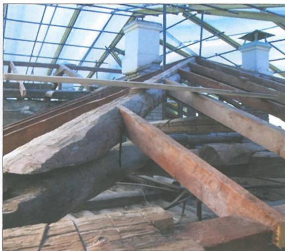
*Стропильная конструкция крыши. Видны подлинные и современные элементы. Снято во время проведения реставрационных работ. 2018*
