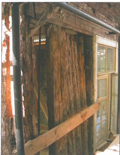
*Состояние деревянных стен второго этажа снаружи после снятия штукатурки. 2018*
