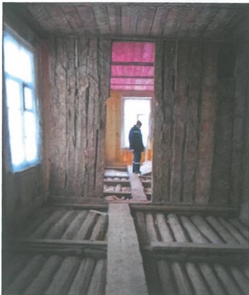
*Конструкция межэтажного перекрытия с накатом из полубревен по деревянным балкам. 2018*
